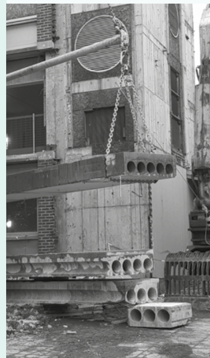
Fra demontering av hulldekker i R4 i Regjeringskvartalet i Oslo. Statsbygg og Veidekke. Foto: Veidekke
