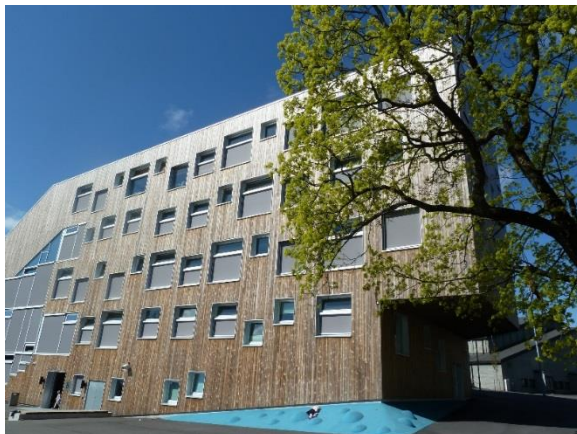
Figur 11: Mesterfjellet skole i Larvik er designet med hybrid ventilasjon tilsvarende prinsippet i alternativ 3.
