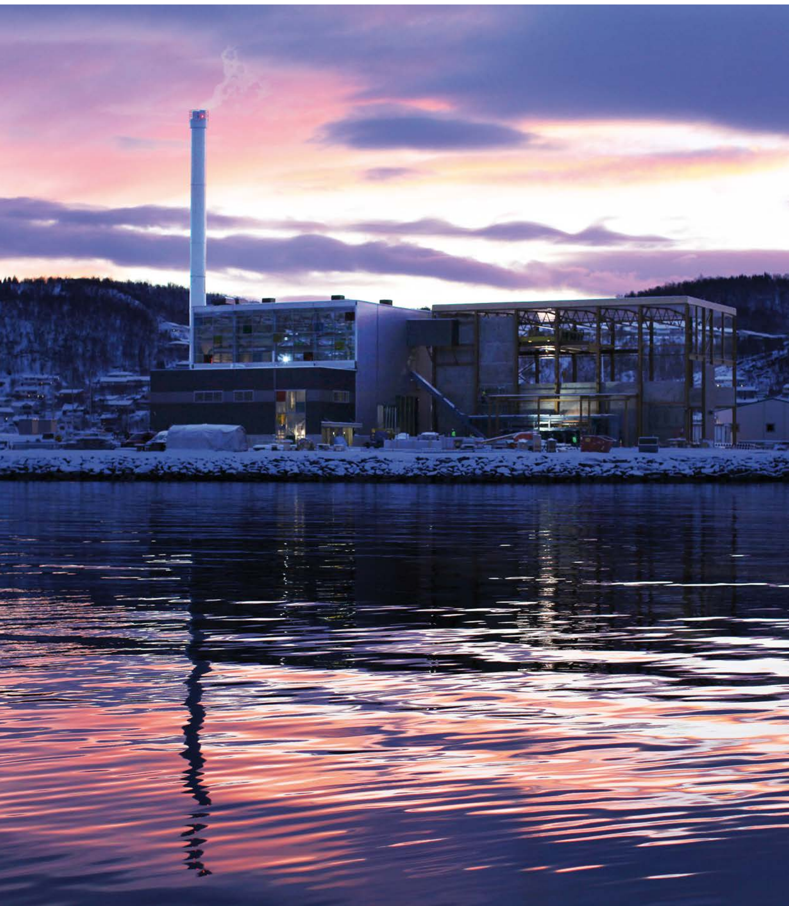
Biobasert fjernvarmeanlegg på Hjellholmen i Harstad. Foto: Inge Trondsen.
