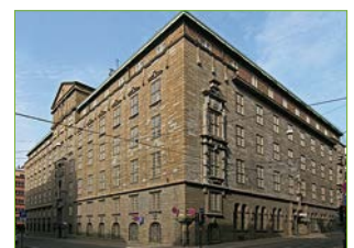
Eksempel på B1 og B2: Telegrafbygningen i Oslo.
