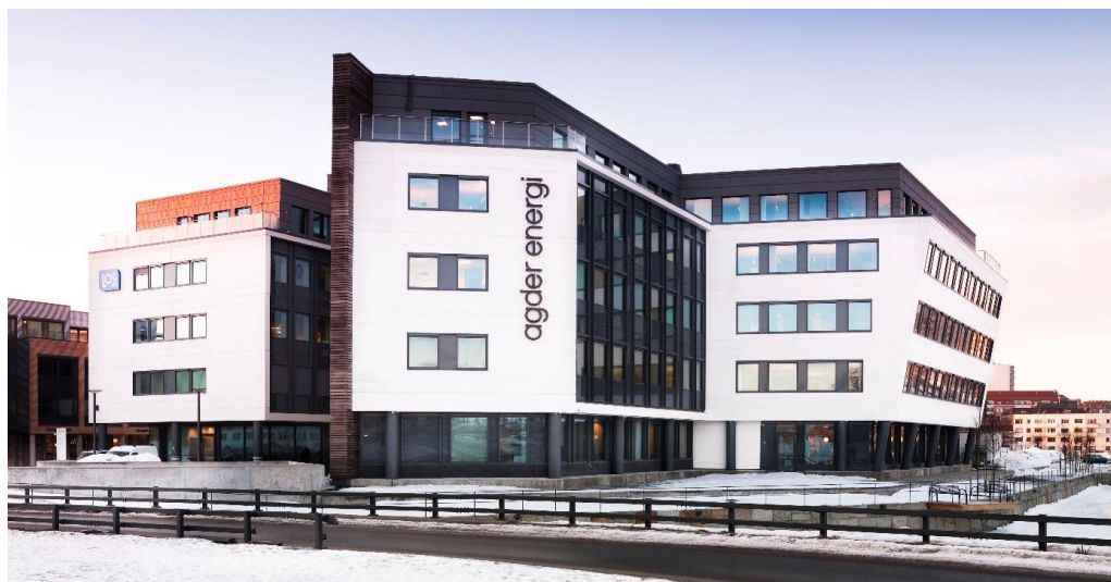
Et vindusareal på 30-45% av fasaden er vanligvis en fornuftig kompromiss mellom krav til daglys, i nneklime og energibruk til oppvarming, kjøling og belysning. Bilde Hundven-Clements Photography/ Link Arkitektur.
