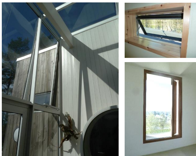
Figur 17: Høytsittende lave vinduer (øverst til høyre) reduserer risiko for trekk og gir god kapasitet ved kryssløfting, men ved ensidig løfting oppnås ikke de samme fordelene. Store høye vinduer gir god luftekapasitet, men gir luft direkte inn i oppholdssonen og øker risiko for trekk. Styling av vindusåpning kan være manuell eller automatisk. Beste og mest kostnadseffektive løsning er trolig en kombinasjon av høytsittende vindu (for vinterløfting) og høye vinduer (for sommerløfting).
