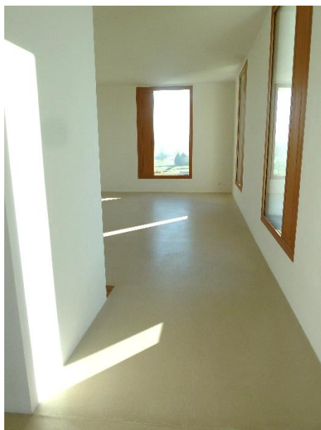
Figur 3: Interiørbilde fra 2226. De eksponerte overflatene sikrer god termisk lagring fra dag til natt og omvendt.
