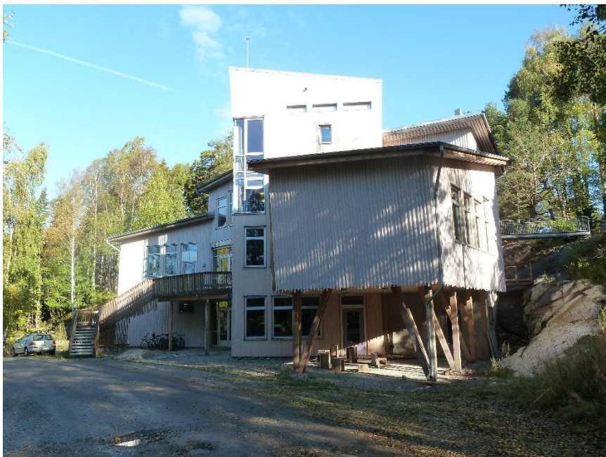
Figur 35: Steinerskolen på Kambo. Bygget er naturlig ventilert.
