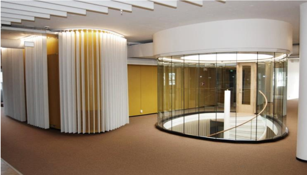
Figur 40: Powerhouse Kjørbo. Akustisk demping er oppnådd med baffler opphengt i dekkekonstruksjonen. Illustrasjon Snøhetta
