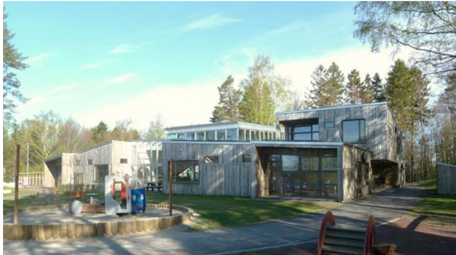
Figur 12: Solstad Barnehage, Larvik. Bygget har hybrid ventilasjon, med kombinasjon av balansert mekanisk ventilasjon og naturlig vinduslufting.
